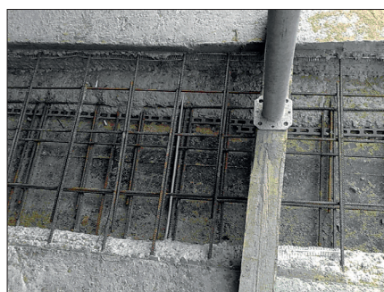
Obr. 2. Vnitřní armování stěn stavby
